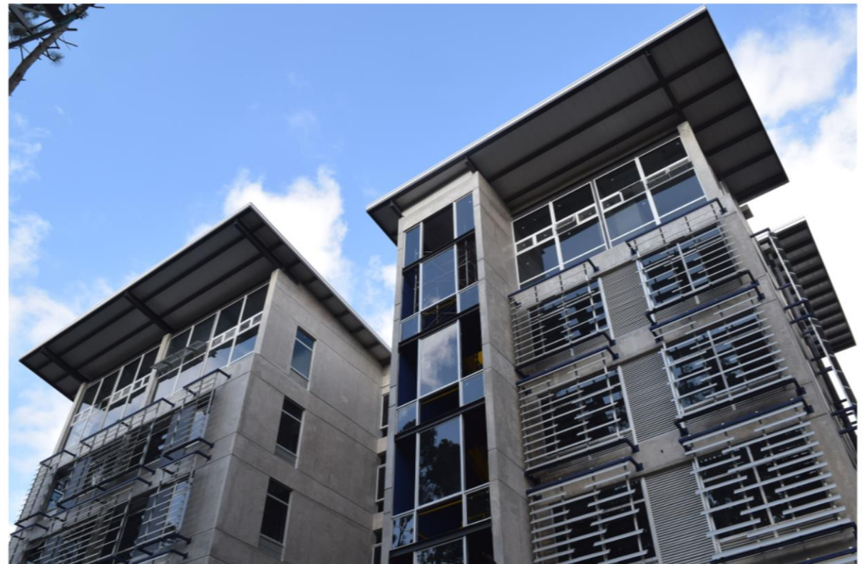
Edificio Anexo (en construcción)
